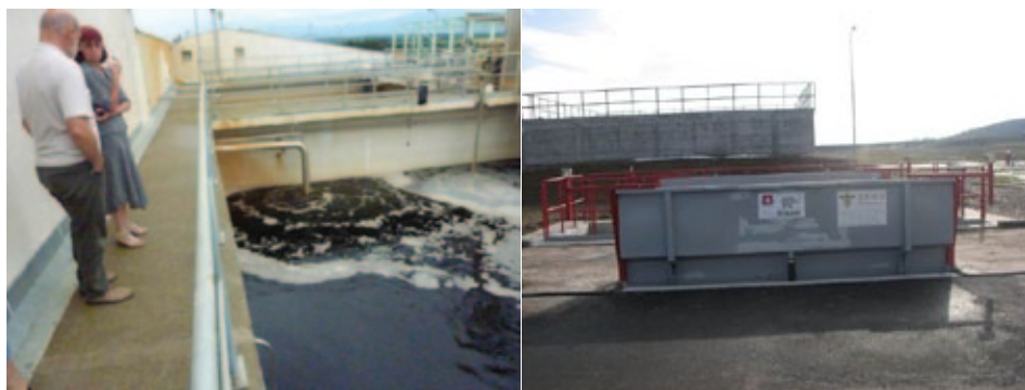
Slika 12. Sistema ravnanja z izcednimi vodami na odlagališčih Birjesnica (levo) in Montana (desno)
