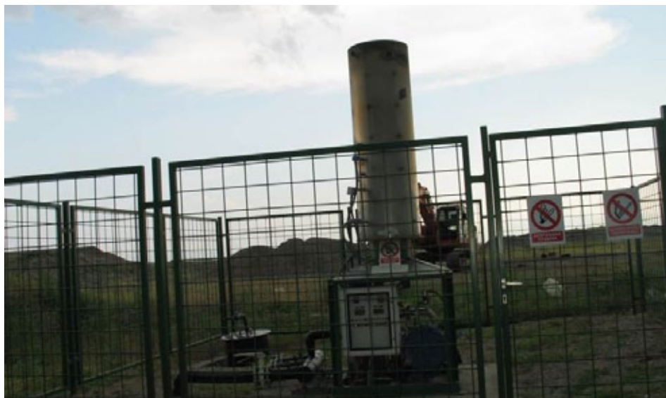
Slika 13. Sežiganje odlagališnega plina na odlagališču Livade
