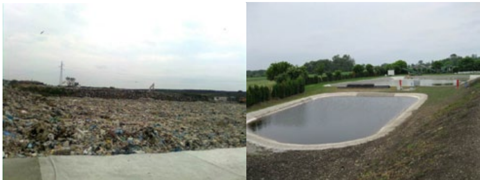
Slika 18. Odlagališče (levo) in ribnik za zbiranje izcedne vode (desno) na odlagališču Totovac
